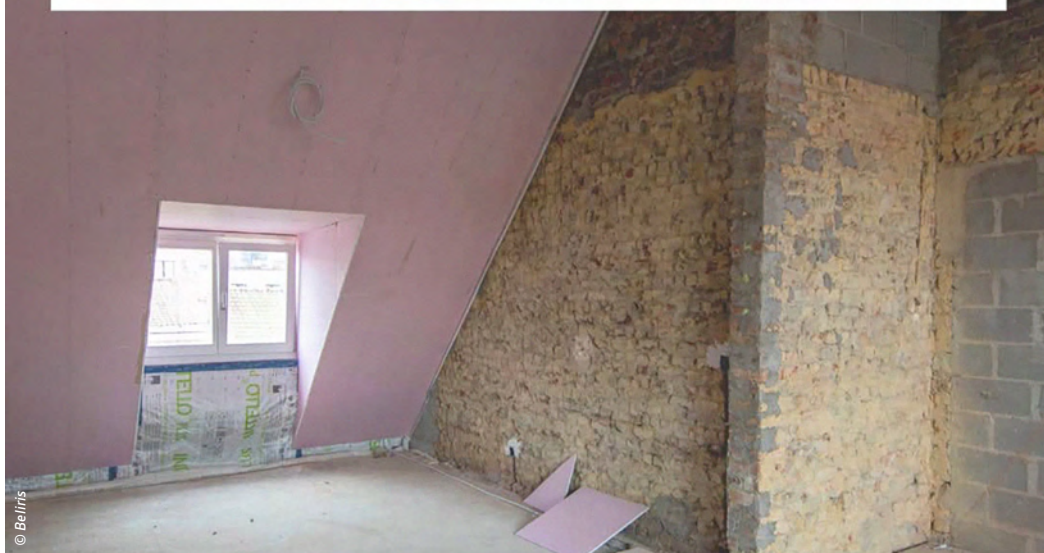
Aperçu avant/après la rénovation d'un logement.
